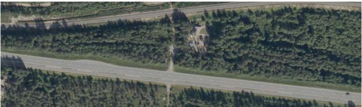
Kuva 4. Ilmakuva Kemijärven karttapalvelusta. Sähkölinjan maakaapeloinnin työura näkyvissä kiinteistön oikealla puolella, menee piha-alueelta kohti tien reunaa.
