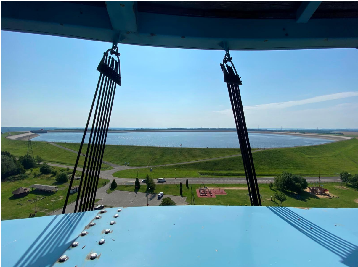
Pumppuvoimalan yläallas näköalatornista kuvattuna.
