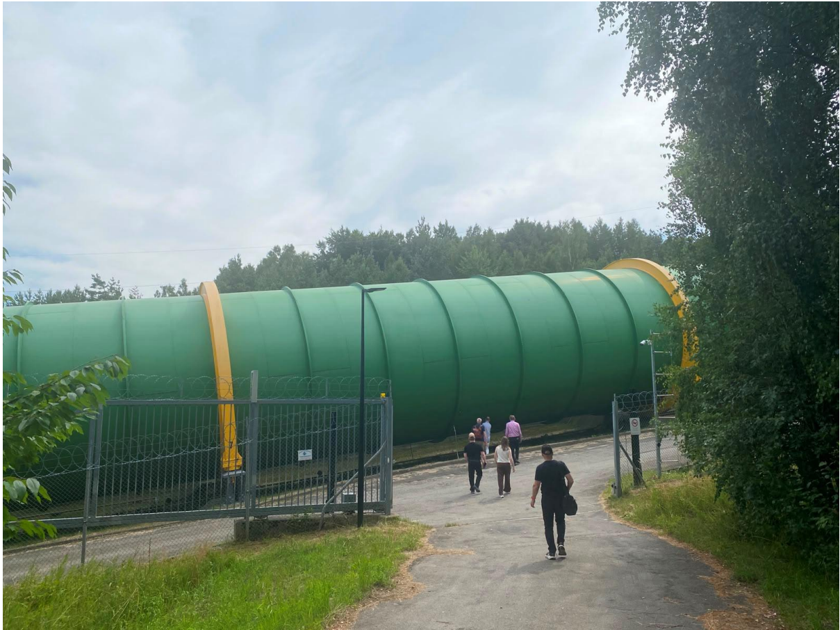
Pumppuvoimalan paineputken keskiosaa kuvattuna.
