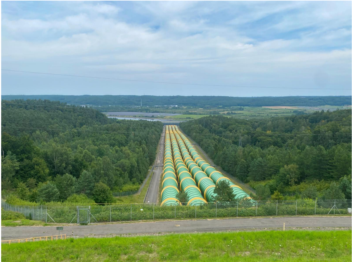
Pumppuvoimalan paineputket yläaltaalta kuvattuna.
